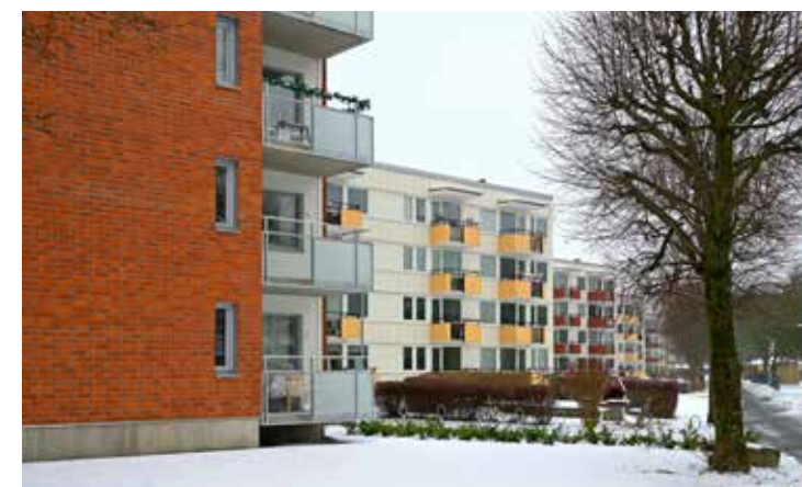
I området blandas nu nybyggda och totalrenoverade hus.
